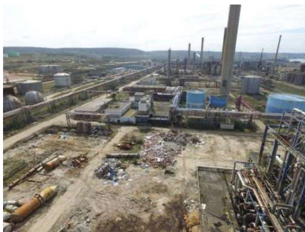
Figure 68 : Etat des démolitions en février 2017
