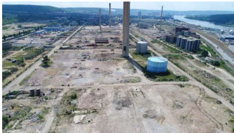
Figure 70 : Etat des démolitions en avril 2019
